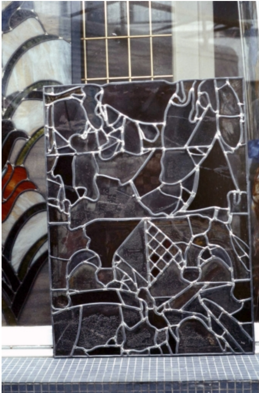
Verrière 1 après restauration, vue prise en atelier Briand à Rennes : panneau 2b, revers, vue d'ensemble.
