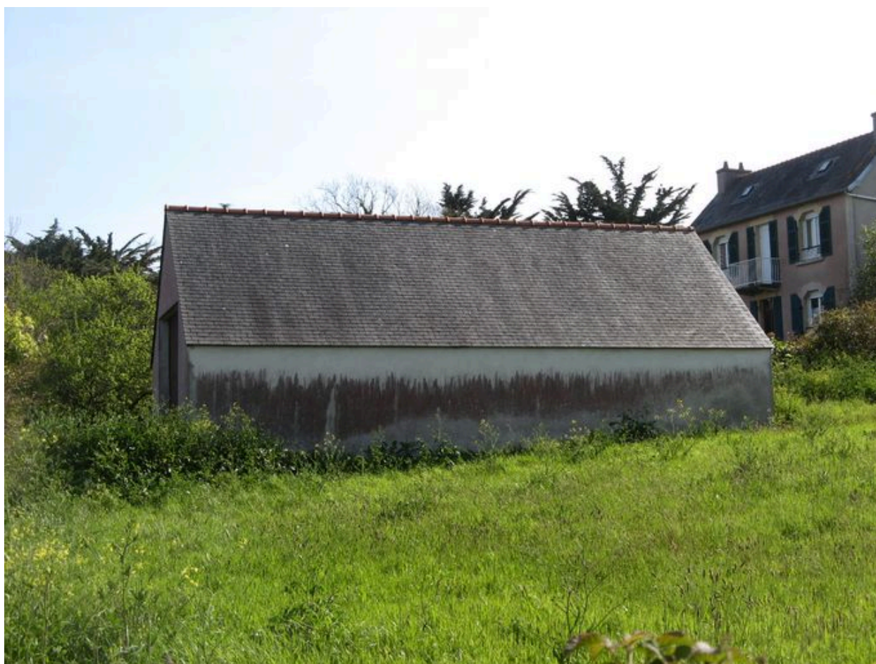
Vue latérale du chantier Laë
