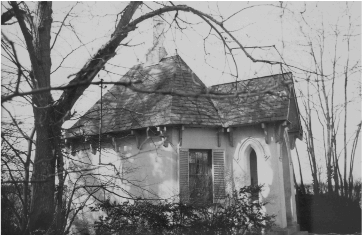
La porterie, état avant transformation
