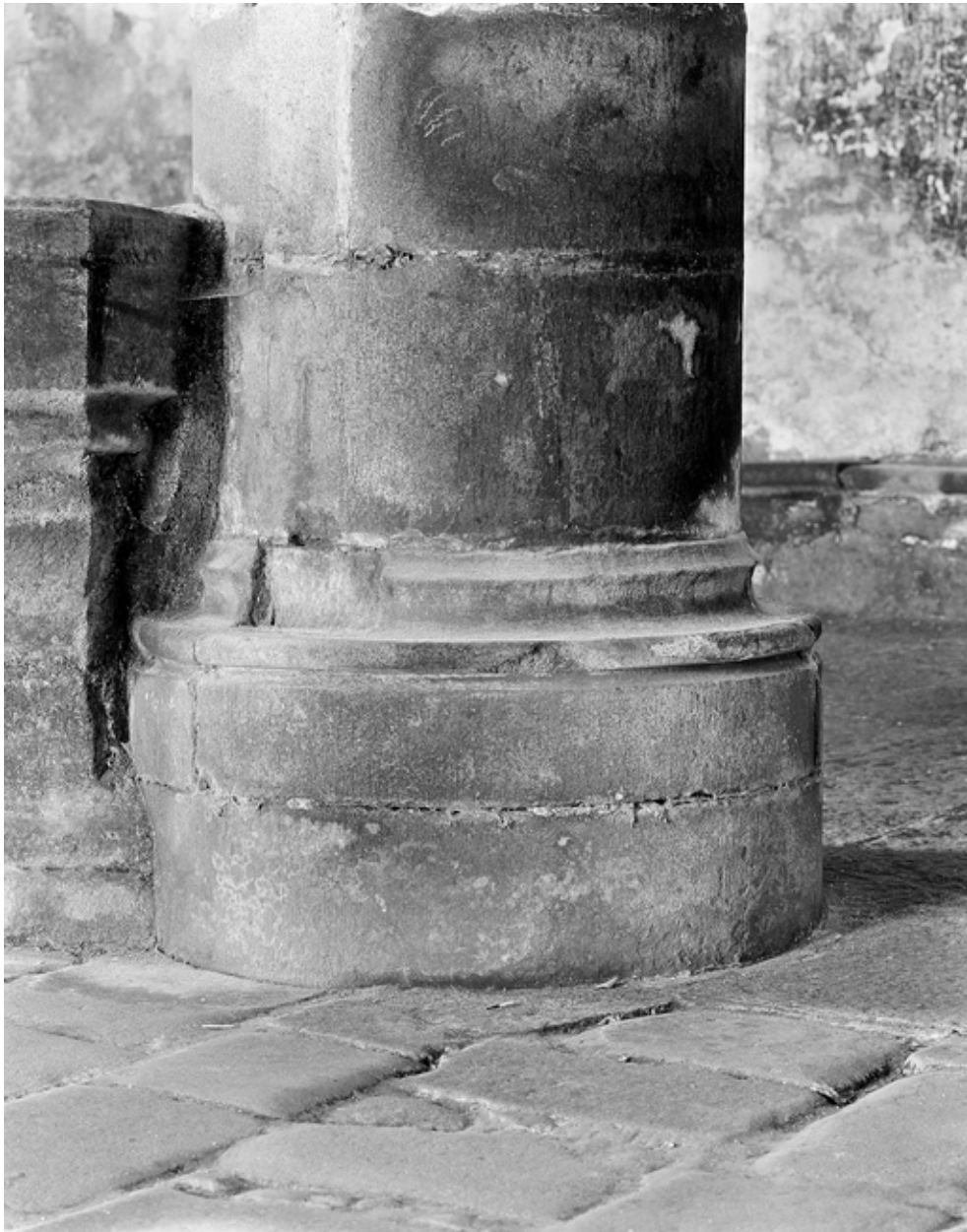
Base de la pile de la nef.
