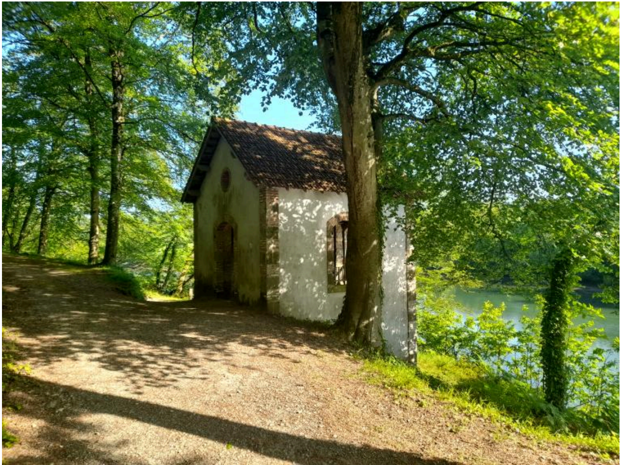
Pavillon d'agrément isolé dans le bois de Sugensou, vue générale prise du sud. (2023)
