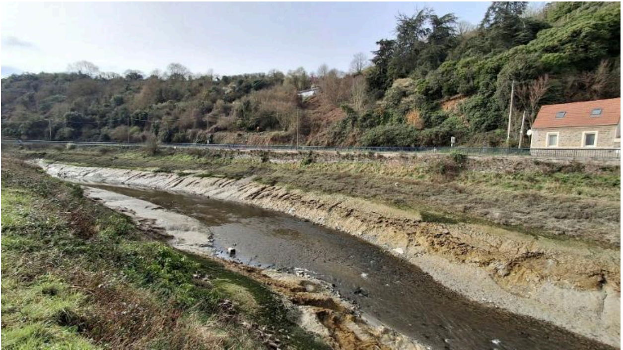
Vue du bras de mer depuis l'île sèche vers le pont déversoir
