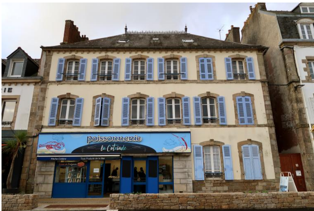
Immeuble au 3, quai Jean Jaurès, élévation antérieure. (2020)
