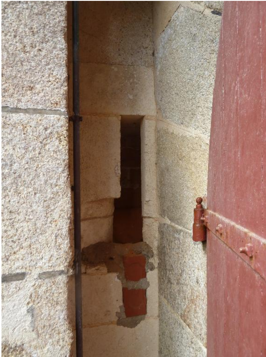
Saint-Pierre-Quiberon, batterie de Beg Quilvi, corps de garde crénelé, créneau de défense de la porte.
