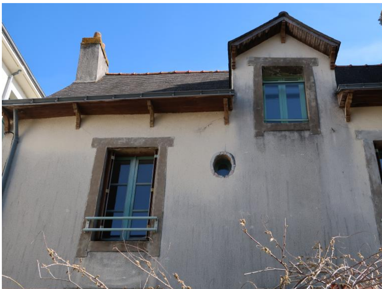
Logement de fonction : détail de la façade.
