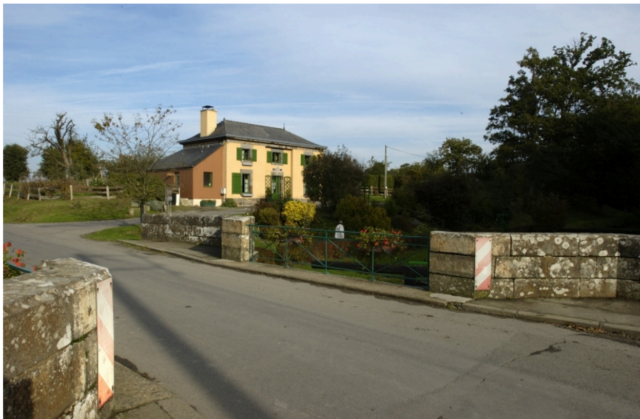
La maison éclusière et le pont
