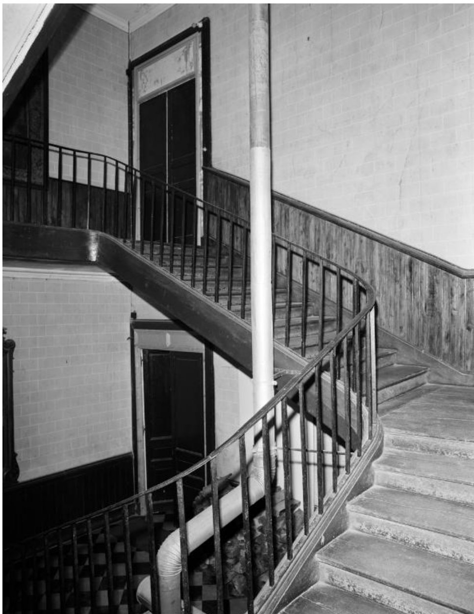
Château, escalier, vue générale.
