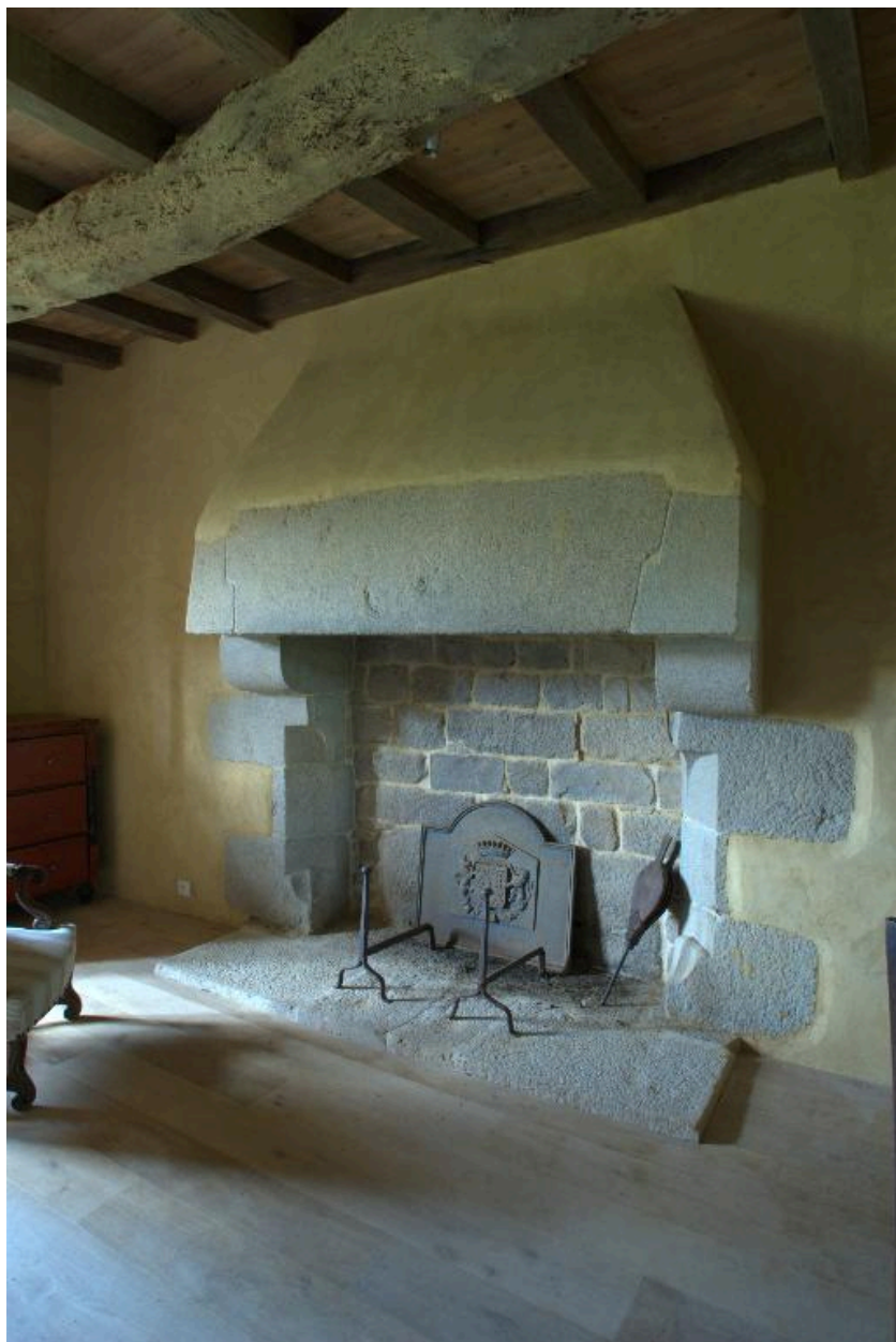
Vue de la cheminée du logis principal
