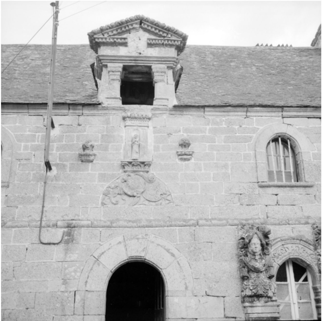
Maison A : détail du décor et de la lucarne au 2ème niveau de la façade est
