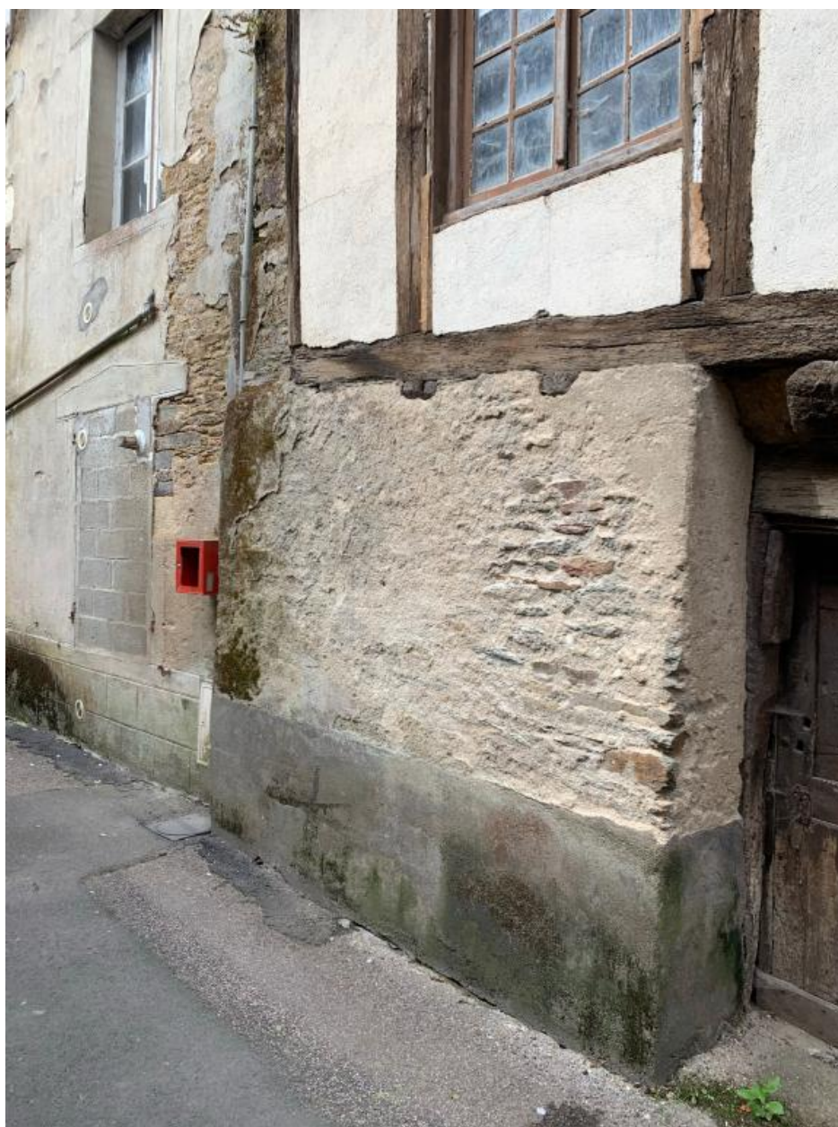
Maison à gauche. Partie sud du rez-de-chaussée
