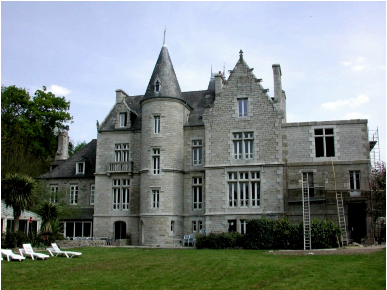
Façade postérieure du corps de logis principal (2003)
