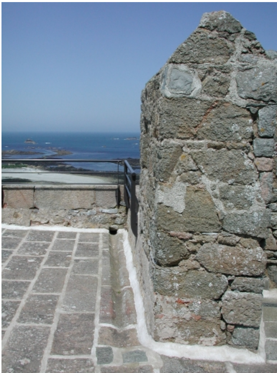
Le circuit des eaux pluviales sur la terrasse dallée du fort
