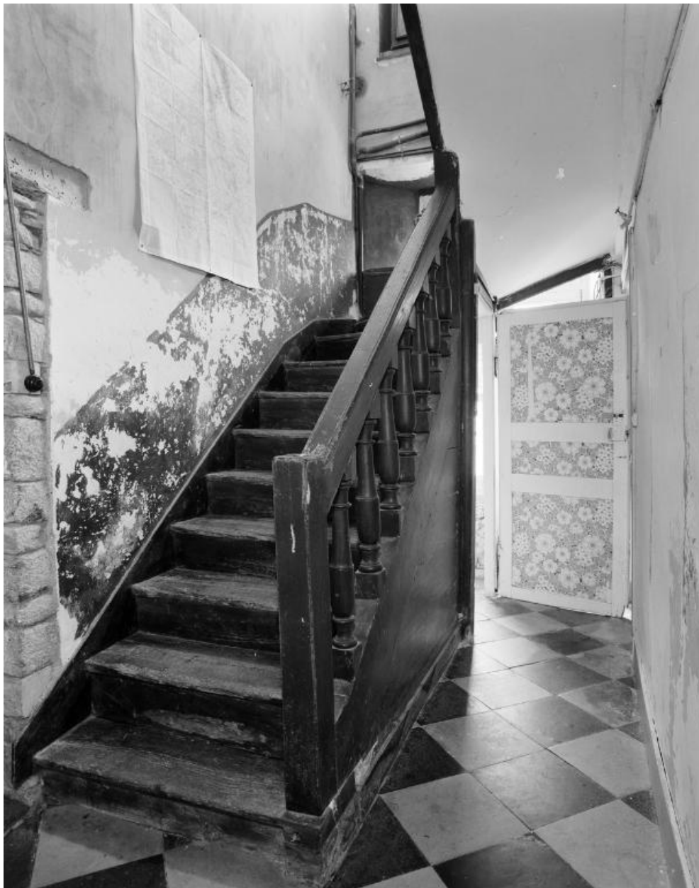
Château, rez-de-chaussée, pavillon ouest, escalier médian.
