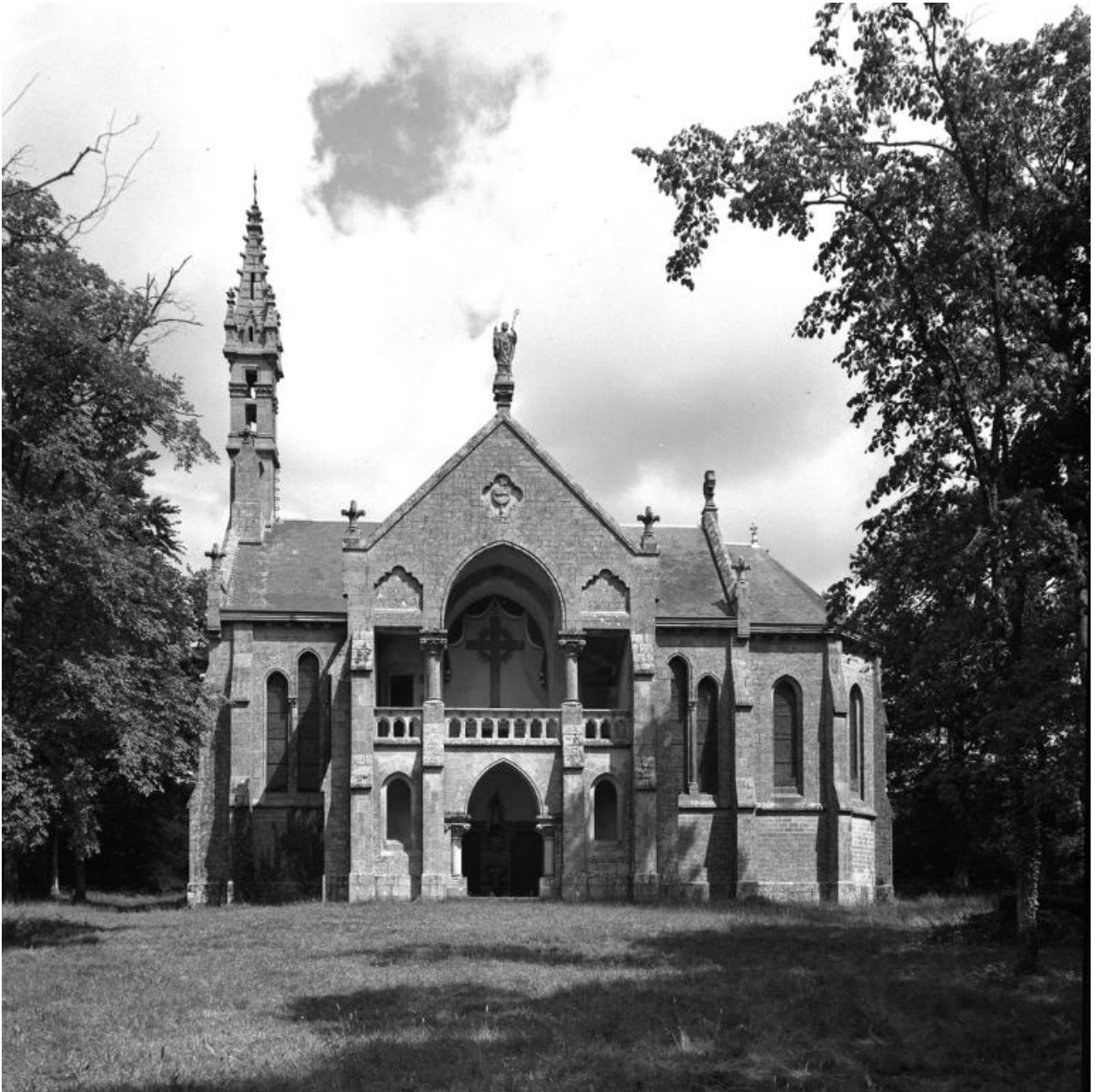
Plomodiern, chapelle Saint-Corentin : façade sud, état en 1970
