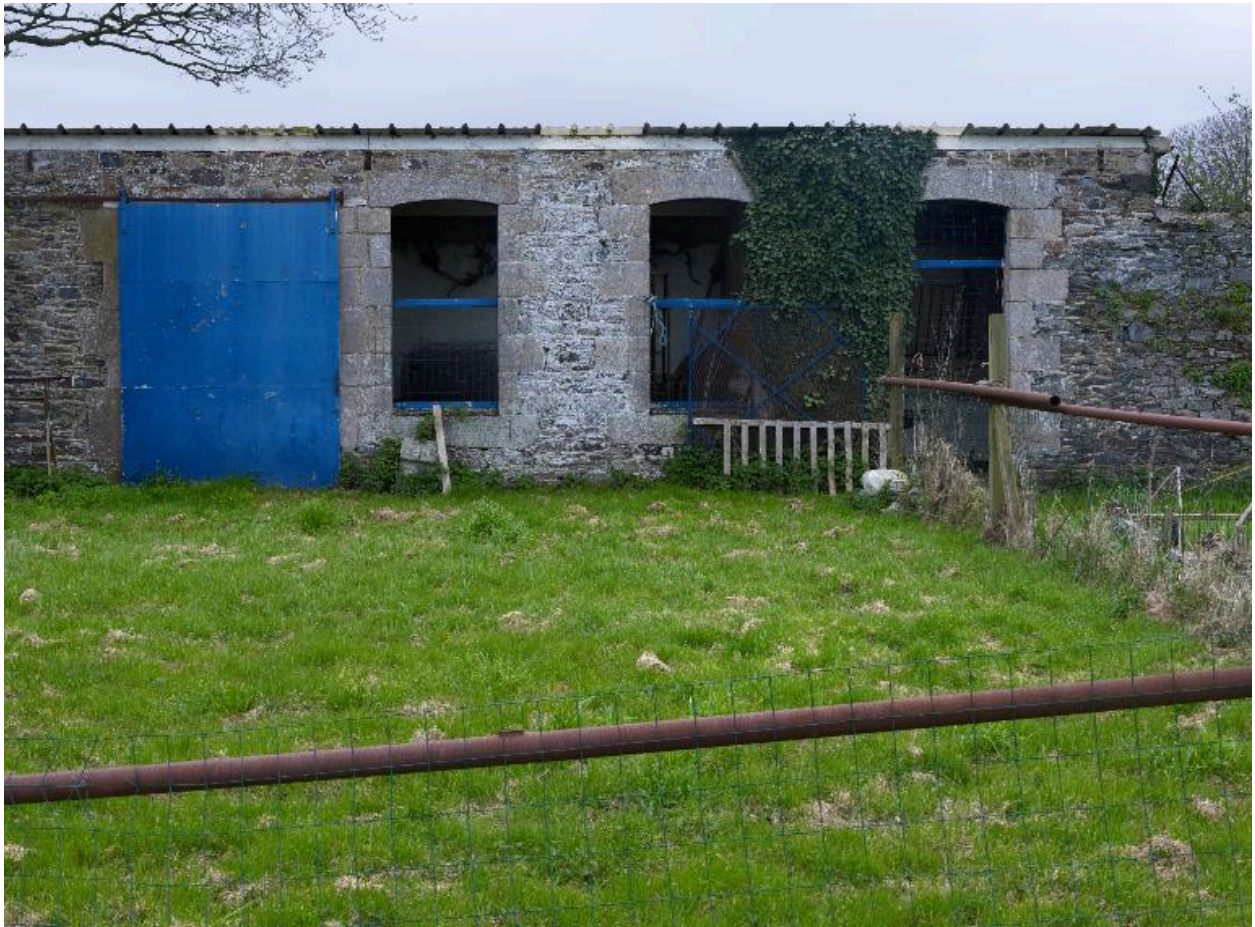
Potager. Orangerie construite contre le mur ouest. Vue générale est
