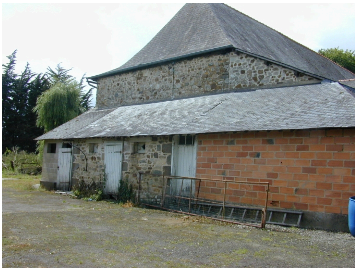
Vue des soues en appentis latéral
