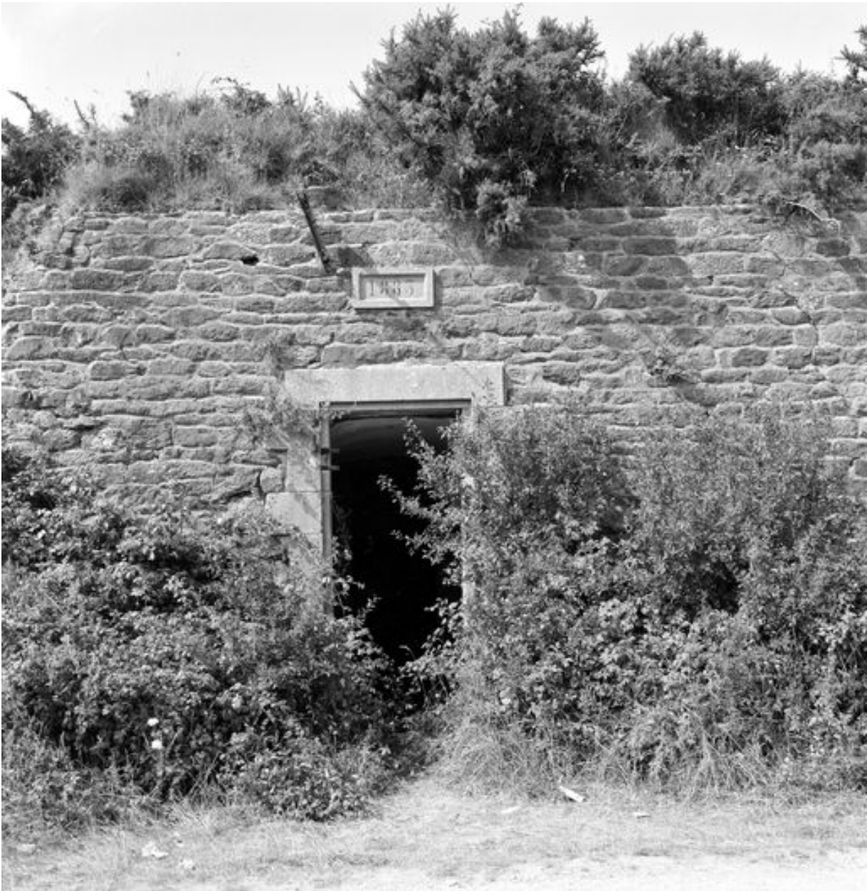
Vue de la batterie de la pointe des Espagnols en 1969 : abri-traverse daté 1883 de la batterie haute
