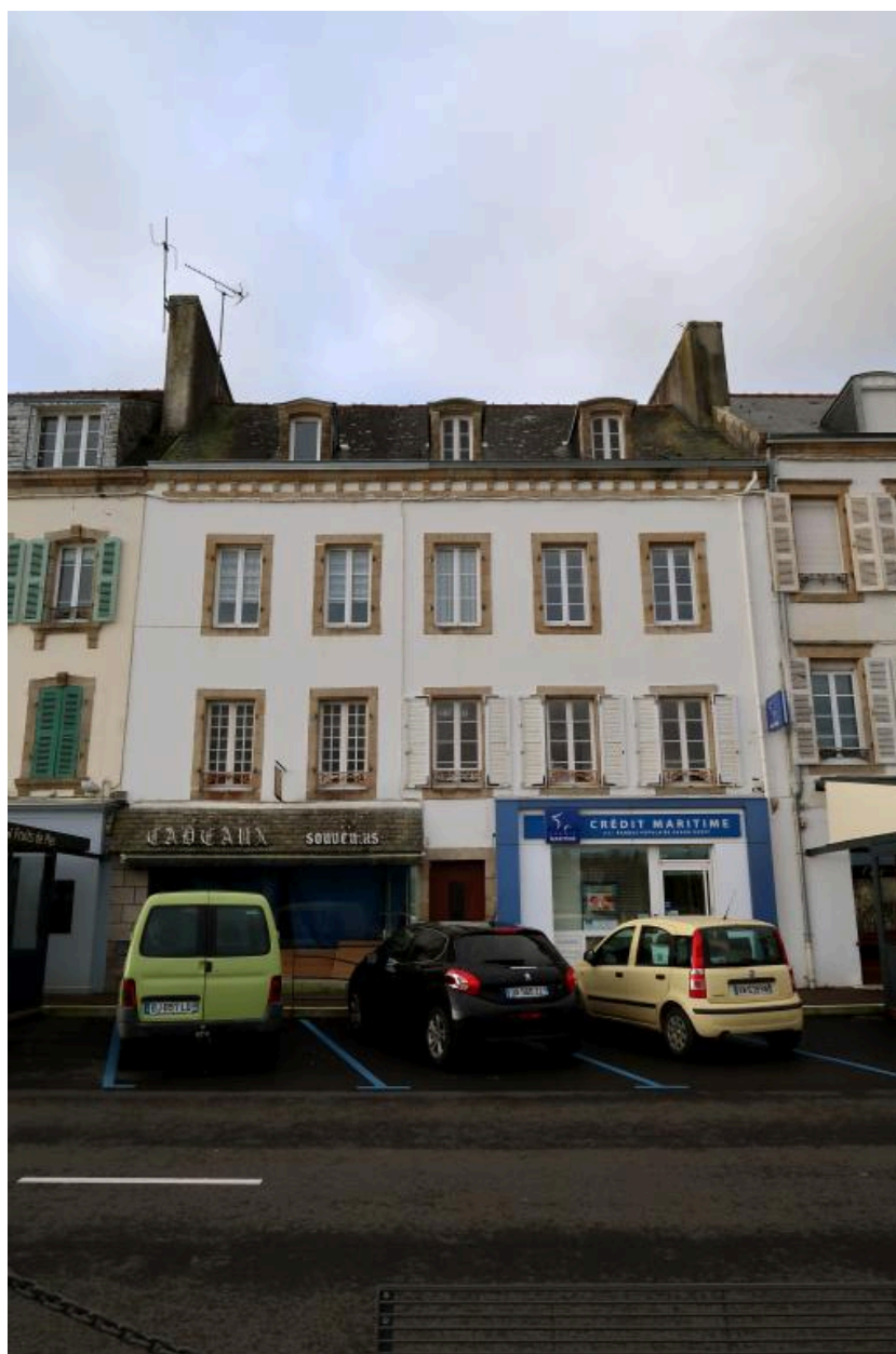
Immeuble au 7, quai Jean Jaurès, élévation antérieure. (2020)
