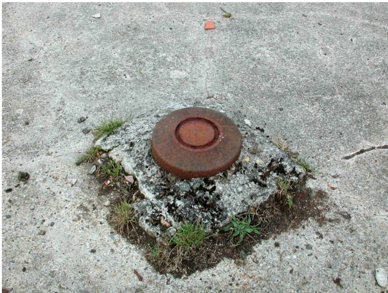
Vue de l'orifice de sortie du périscopes du bunker avec son bouchon de protection encore en place (état en 2003)
