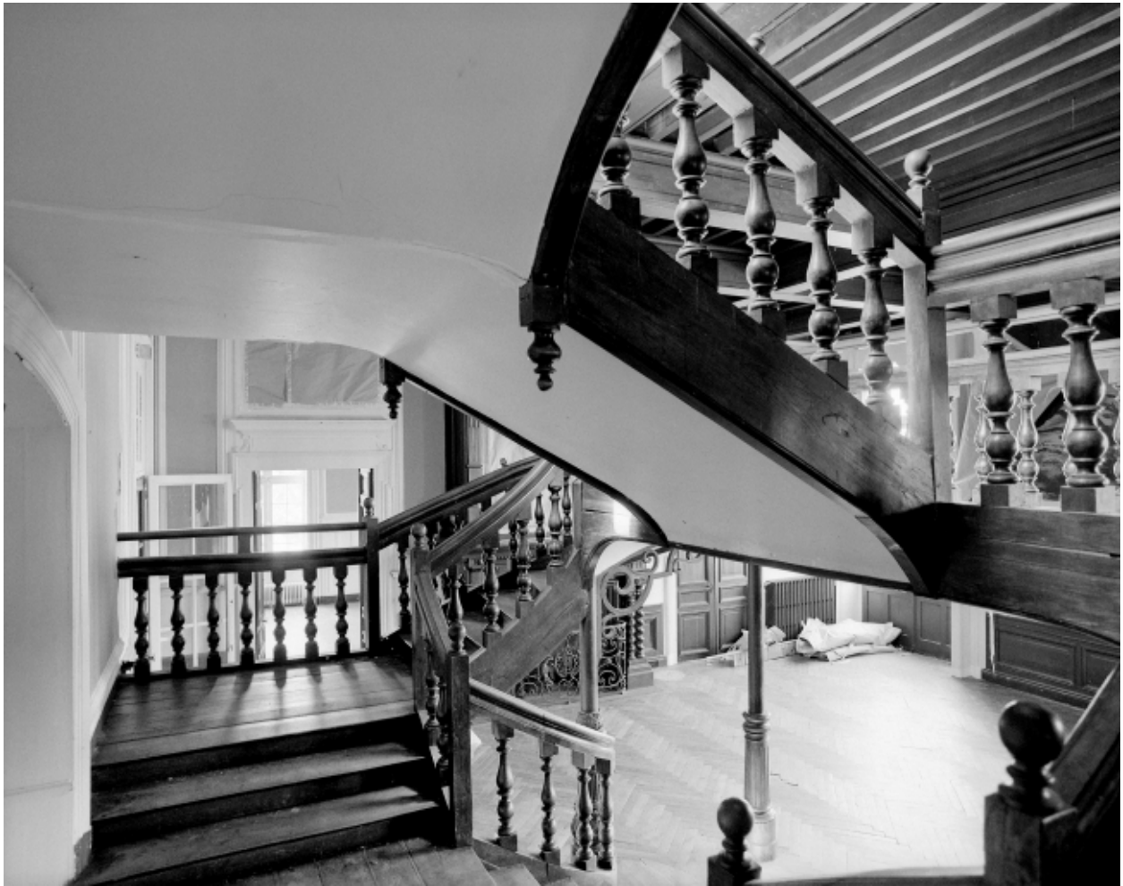
Escalier central du hall d'entrée, palier de repos et 2e volée.
