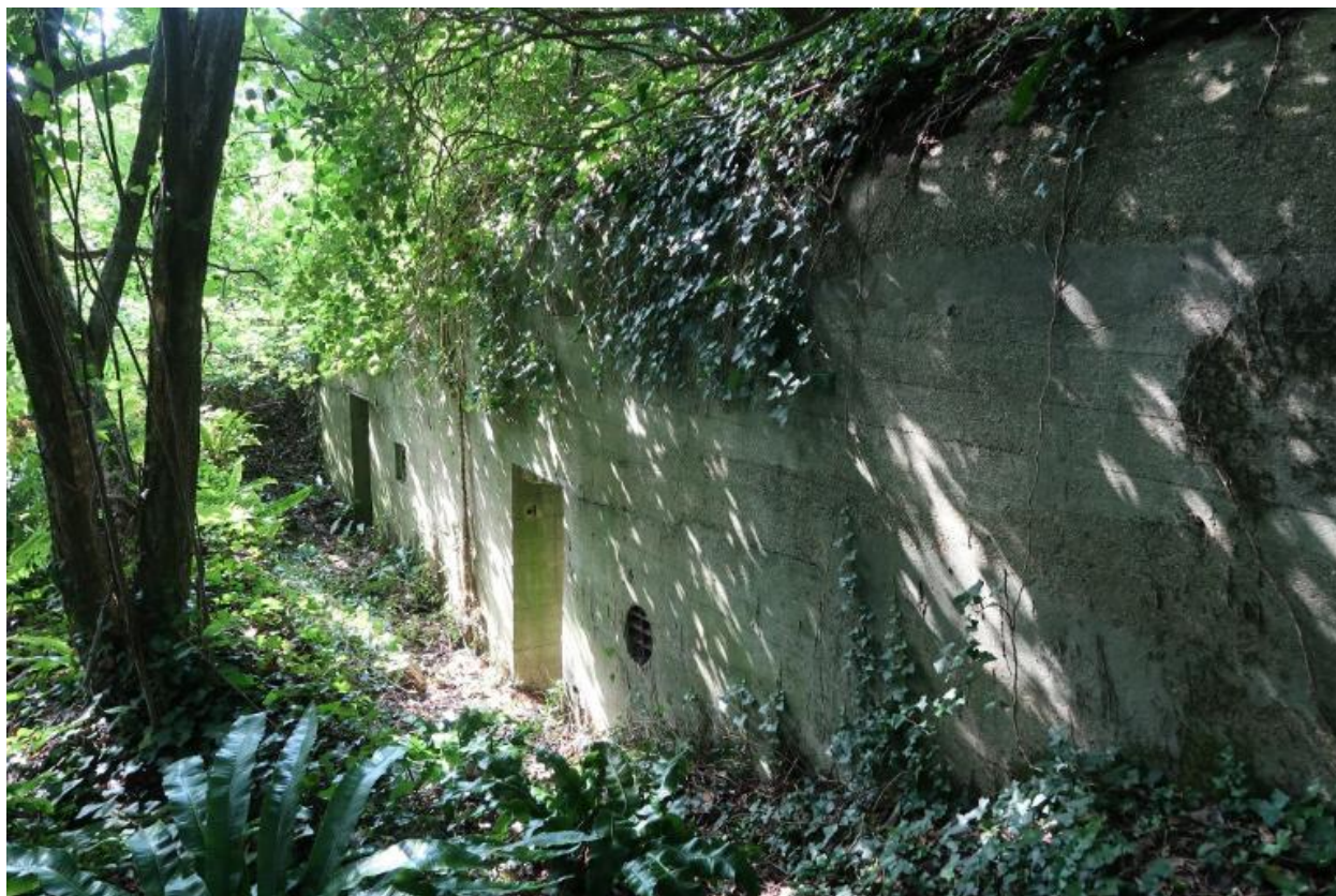
Vue générale : accès et élévation sud percée de deux entrées
