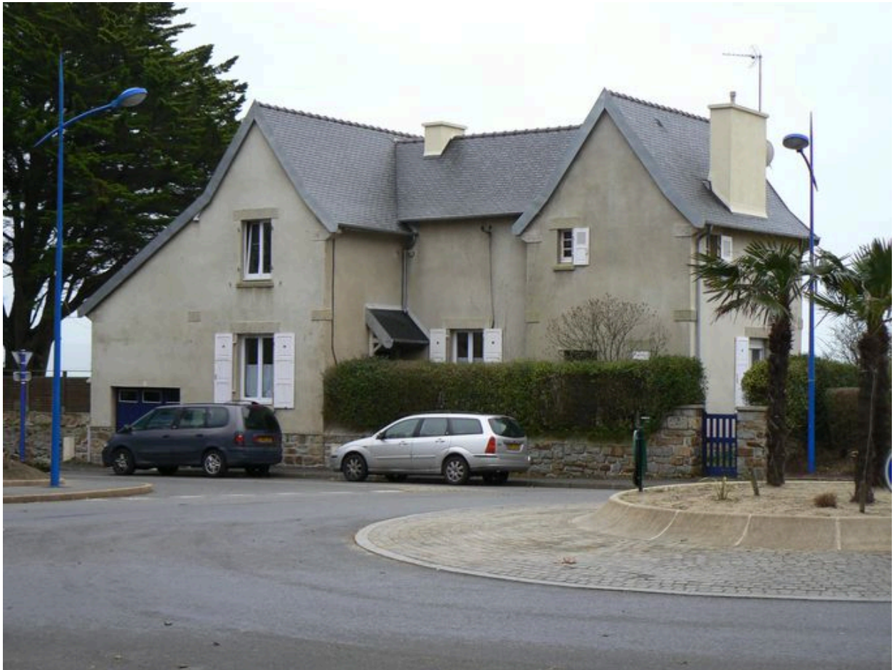
Vue arrière de la villa Ker Bili, côté terre
