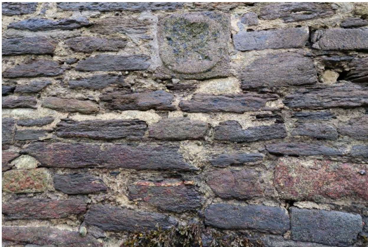
Détail maçonnerie de la cale Est du Drellac'h
