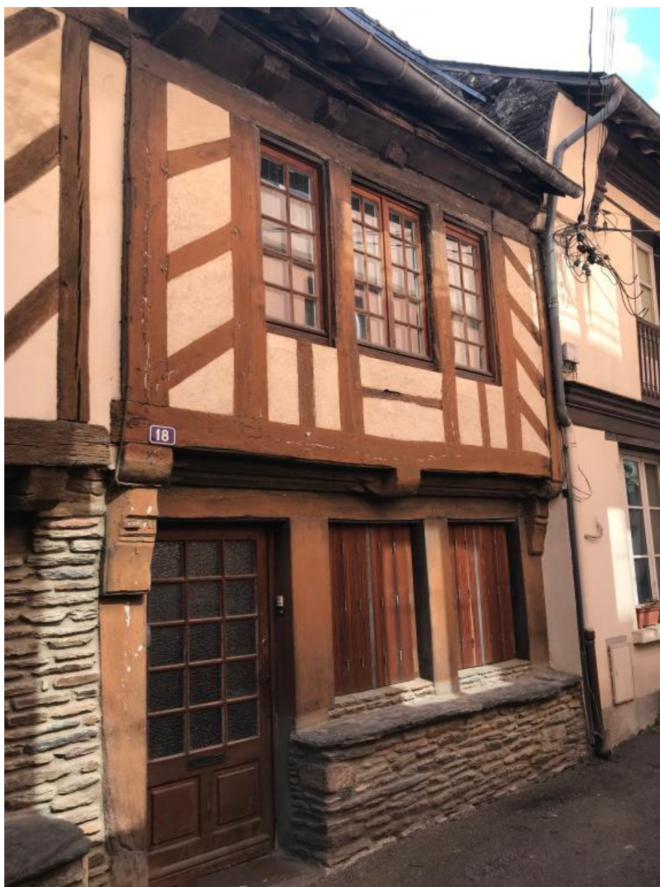
Maison à droite. Vue générale
