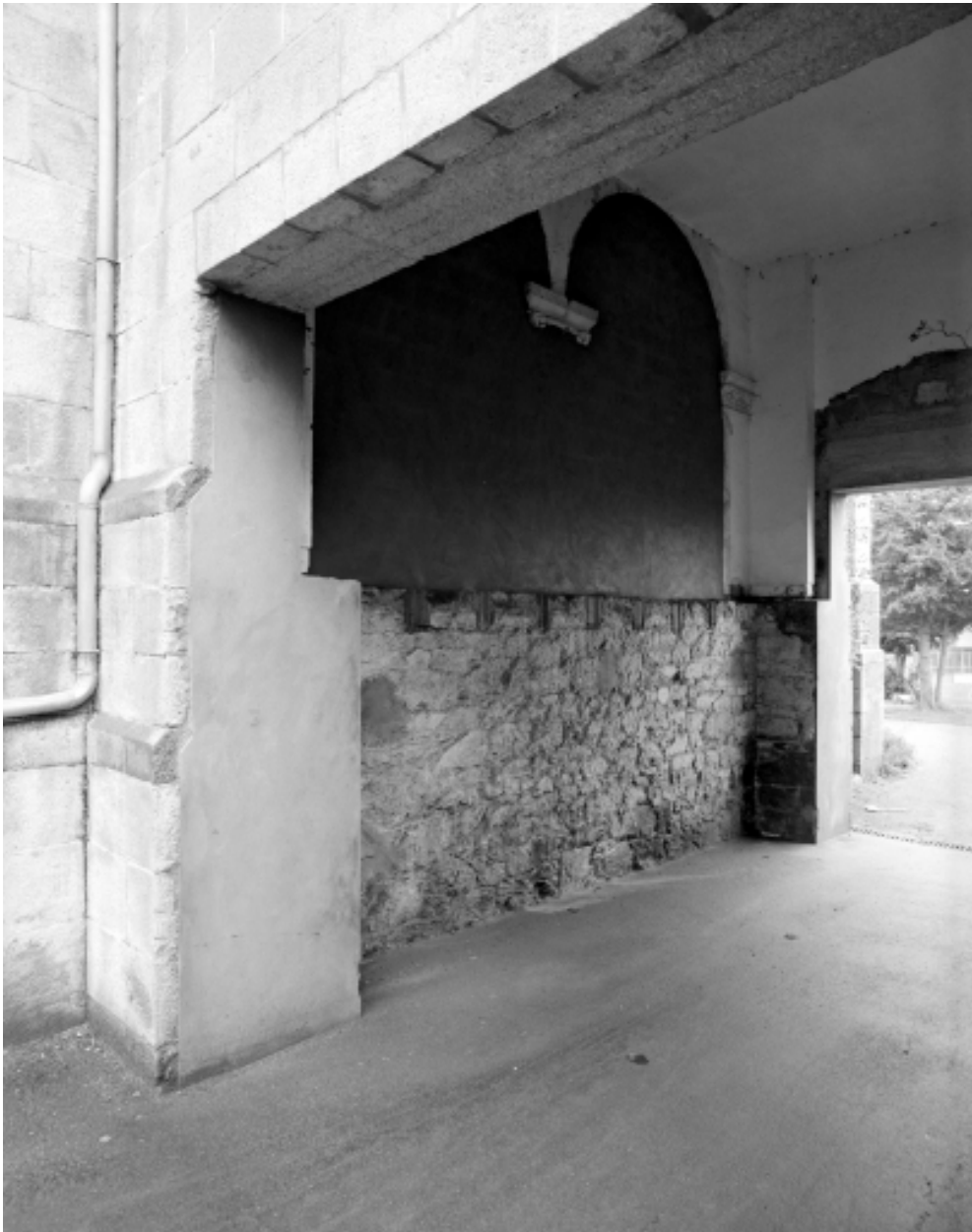
Elévation Sud, chapelle latérale : vue générale
