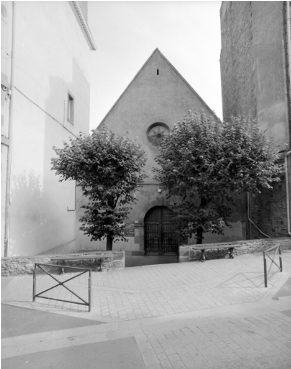
Elévation Ouest : vue générale
