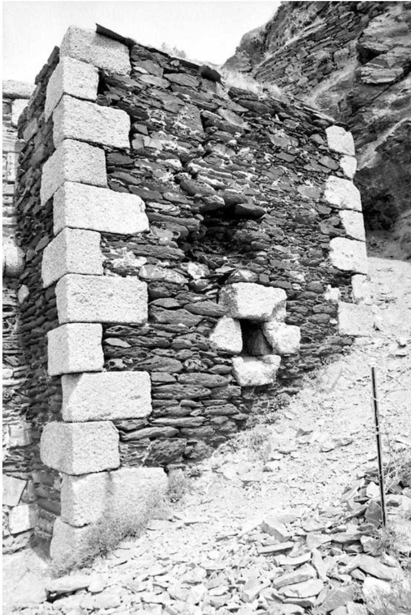
Vue de la batterie de Cornouaille en 1967 : extrémité ouest, latrines, chaînes harpées en pierres de taille de granite
