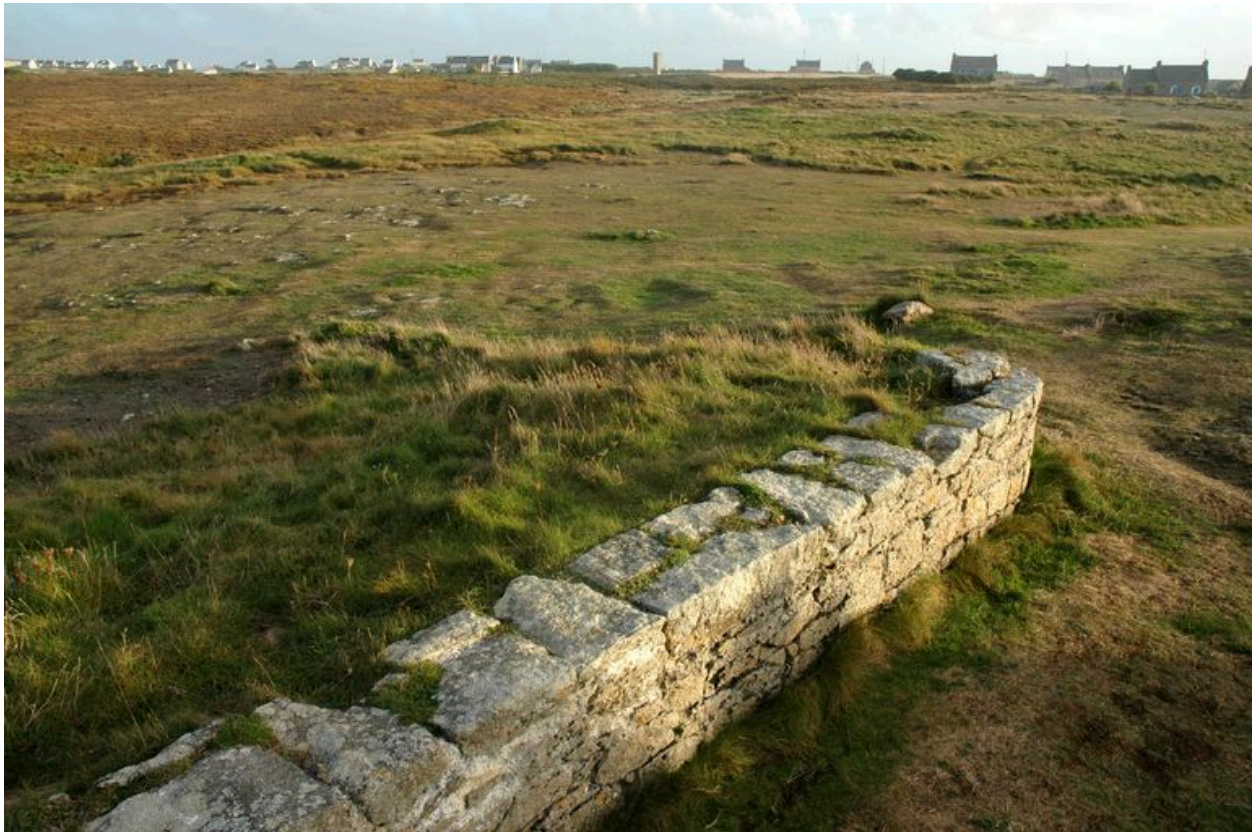
Vue de détail du mur de genouillère en maçonnerie du parapet
