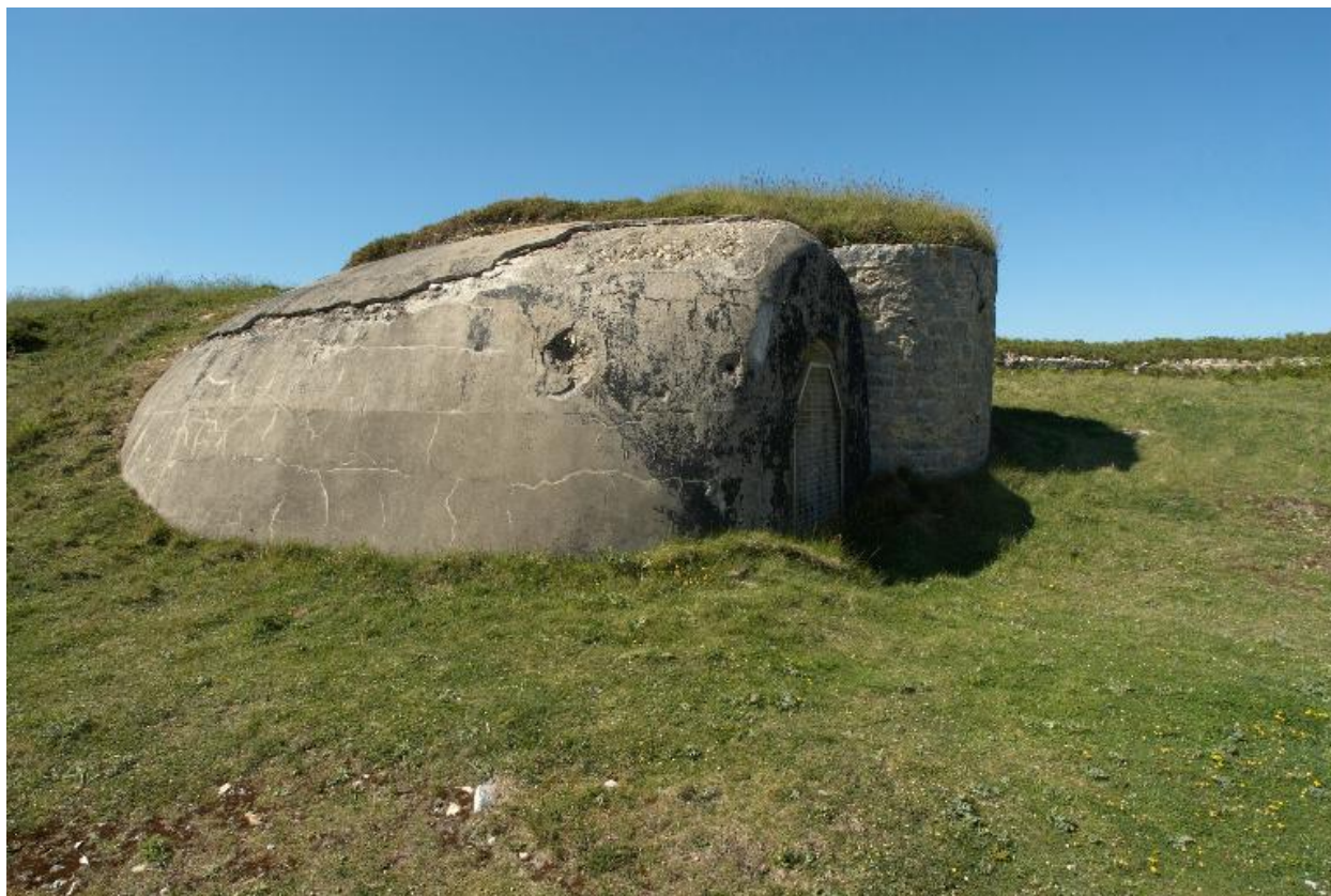
Camaret, pointe du Toulinguet : batterie de côte, abri bétonné
