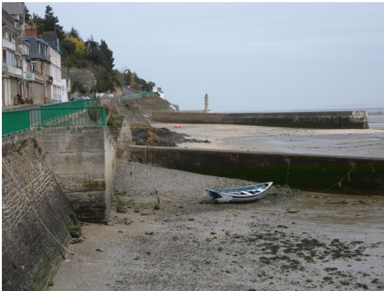
Vue des murs de soutènement, de la jetée de la Douane et du môle à marée basse
