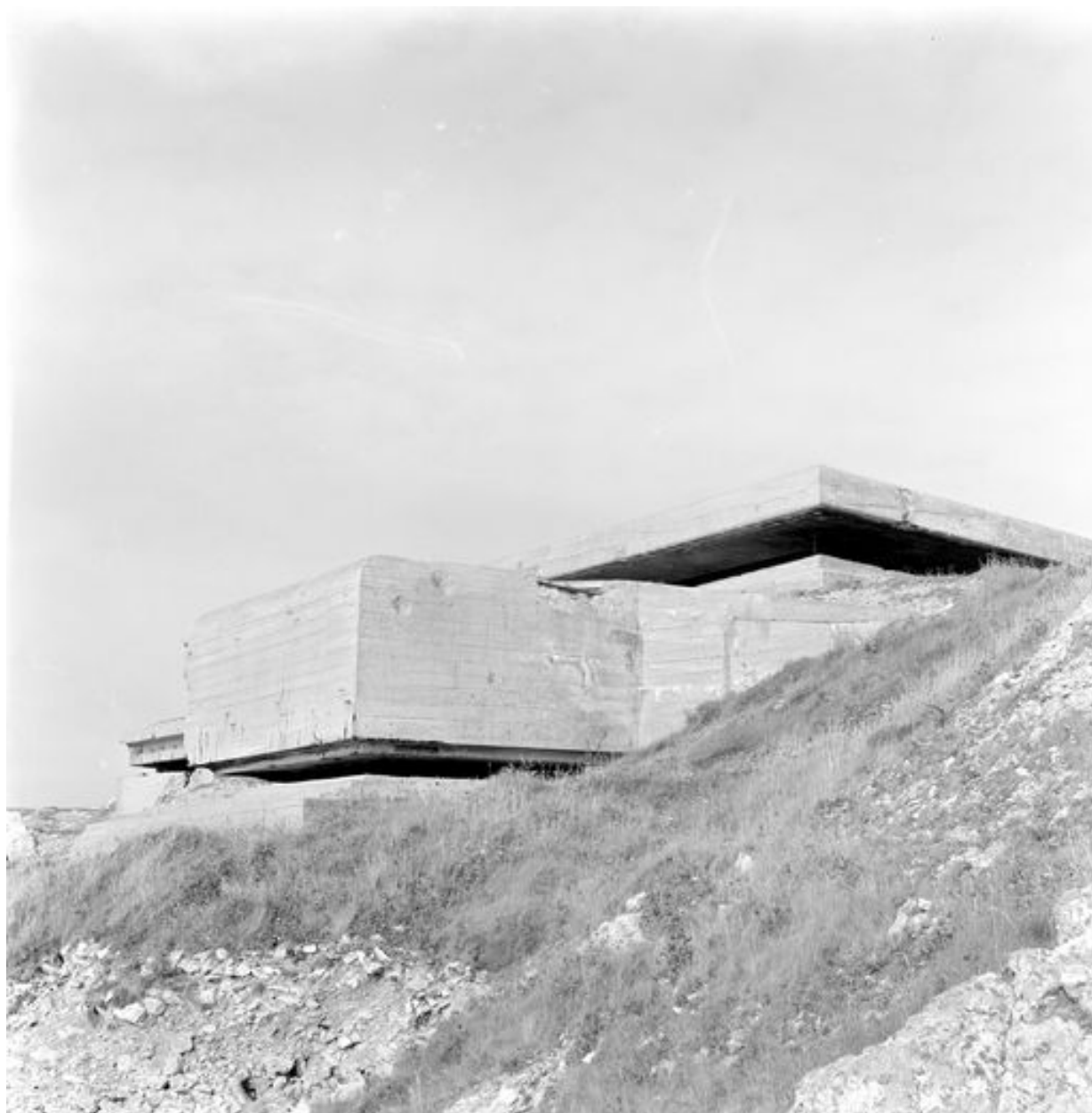
Vue de la batterie de Kerbonn en 1969 : bunker - poste de direction de tir de type M162a
