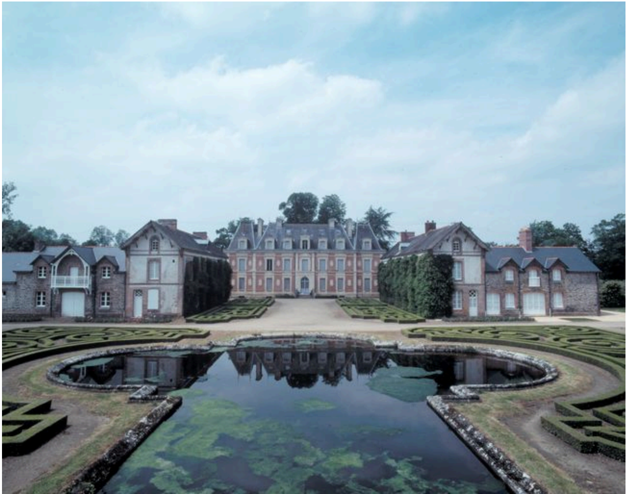
Château et dépendances : vue générale prise du sud-est
