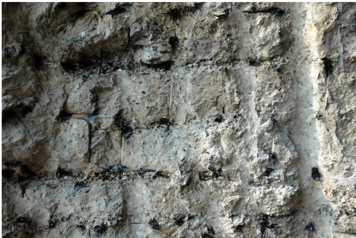
Vue de détail du résultat du percement
