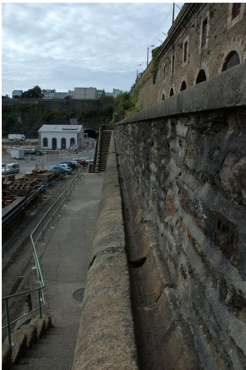
Vue de détail : rigole en granite destinée à collecter les eaux pluviales de la chaussée -
