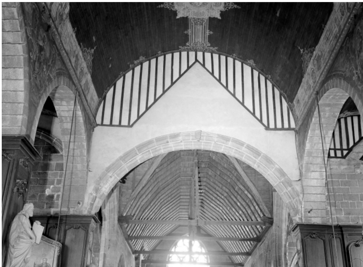
Arc-diaphragme, côté chœur, vue générale.
