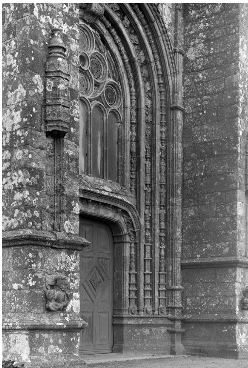
Portail ouest : détail de l'ébrasement droit
