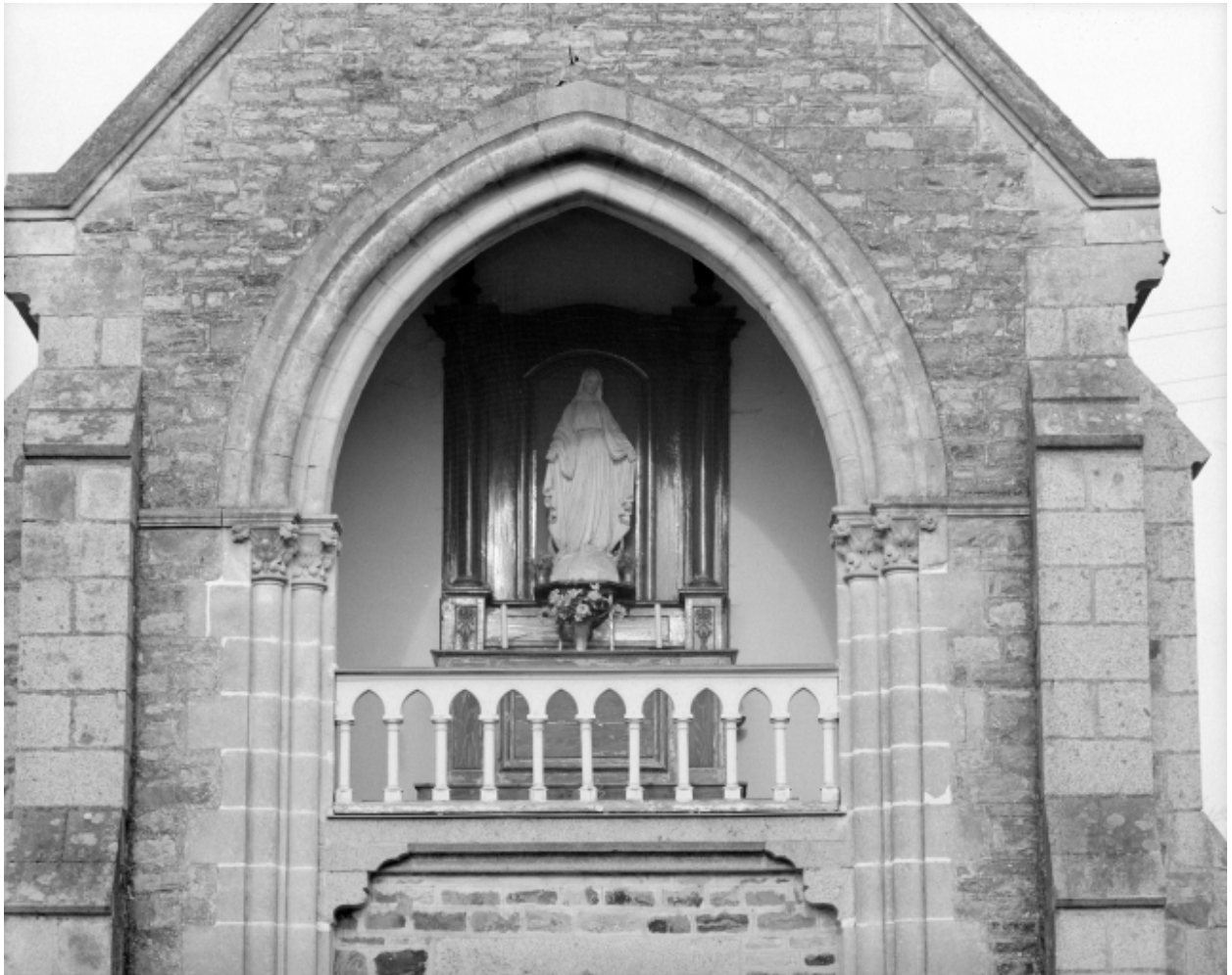
Elévation ouest, détail de la tribune
