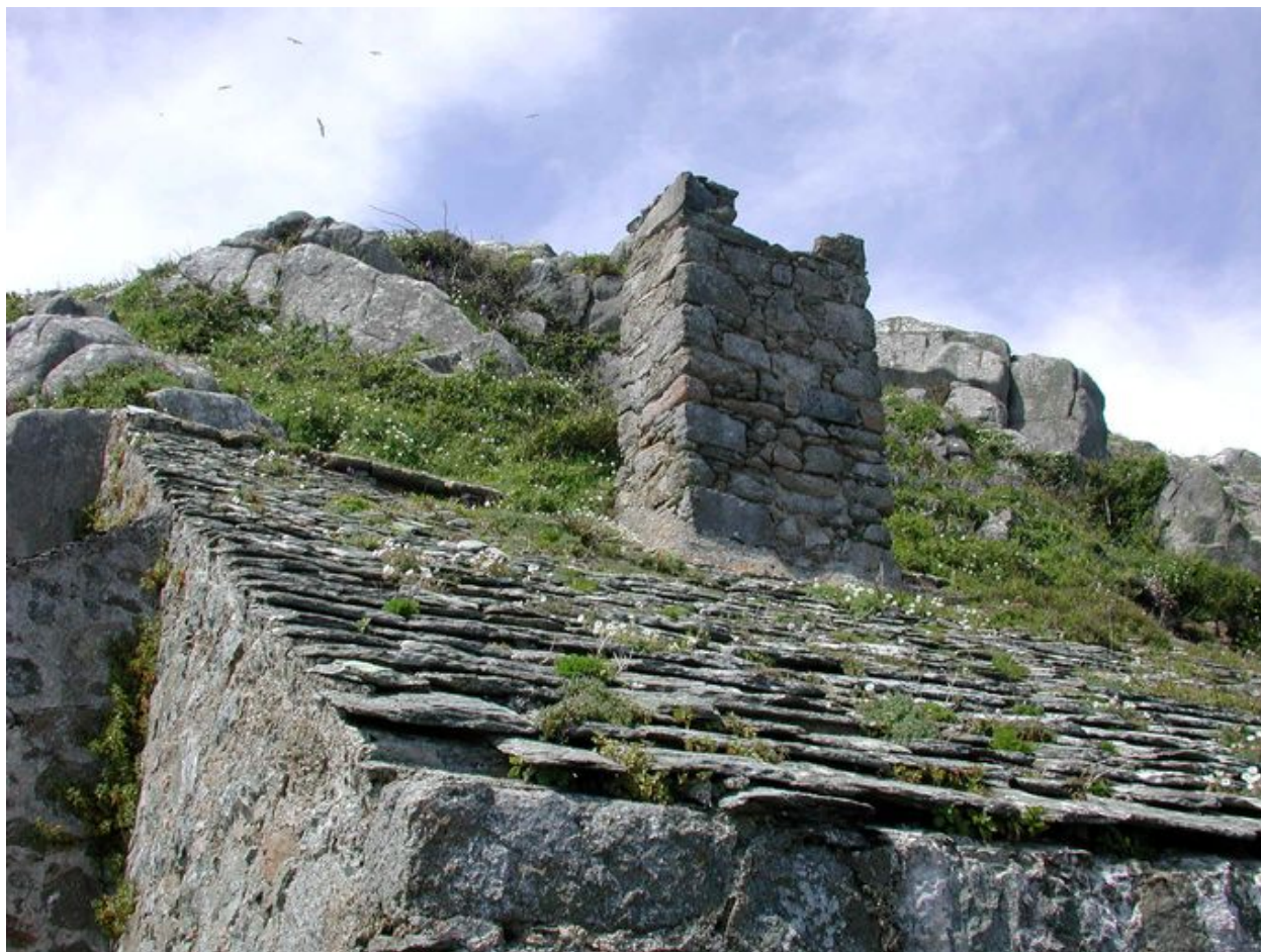
Vue du corps de garde : couverture en ardoises épaisses (état en 2002)
