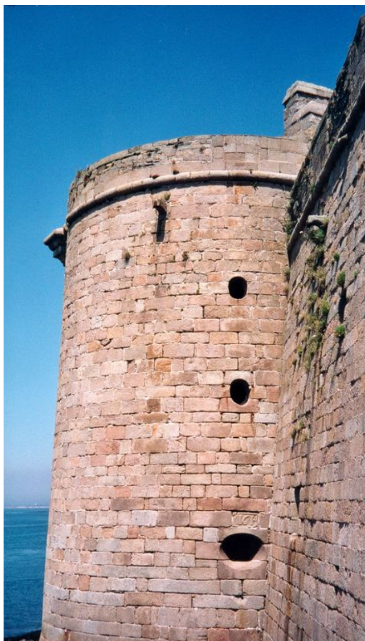
Vue du château du Taureau : la tour Française avant restauration (état en 1999)
