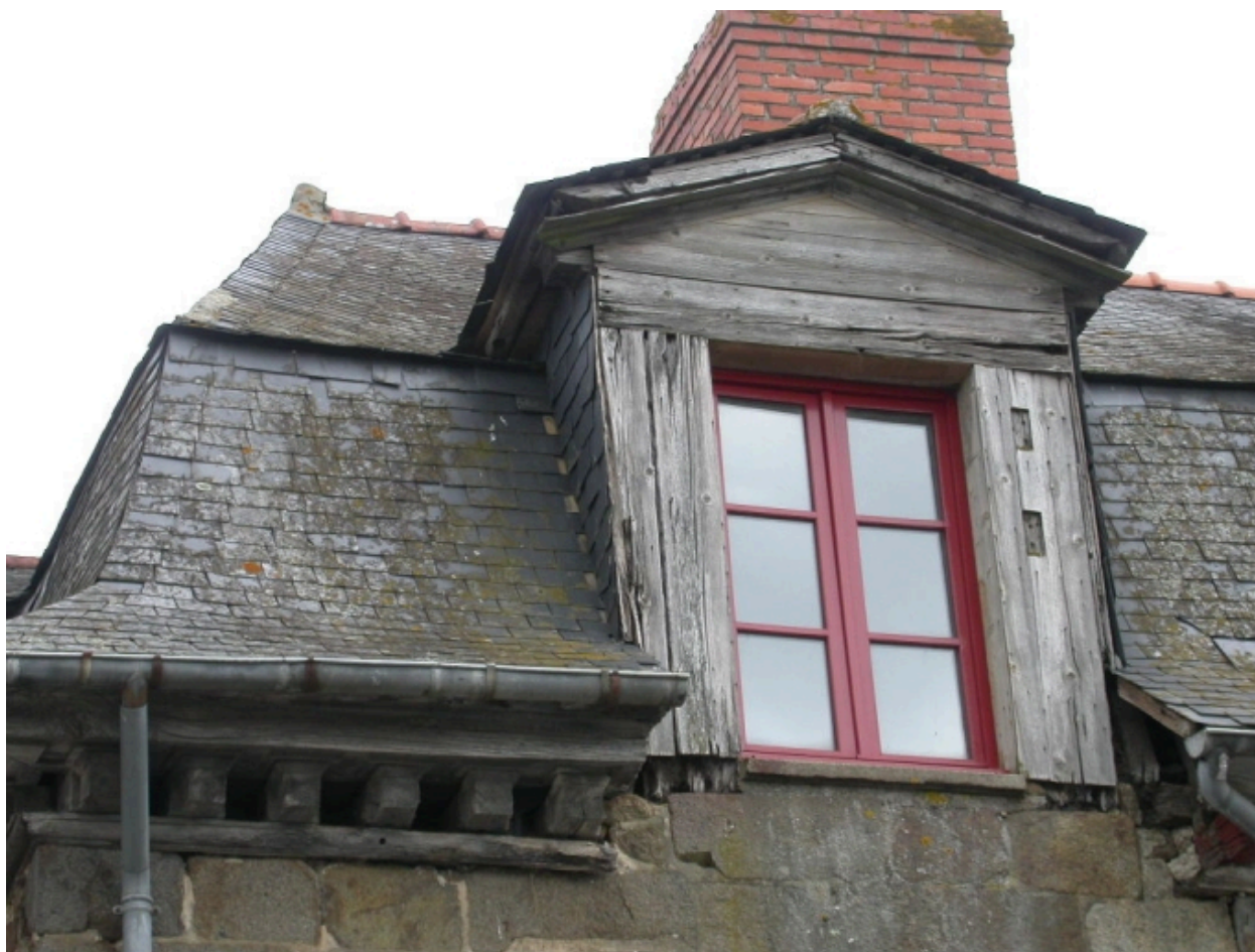
Détail d'une lucarne
