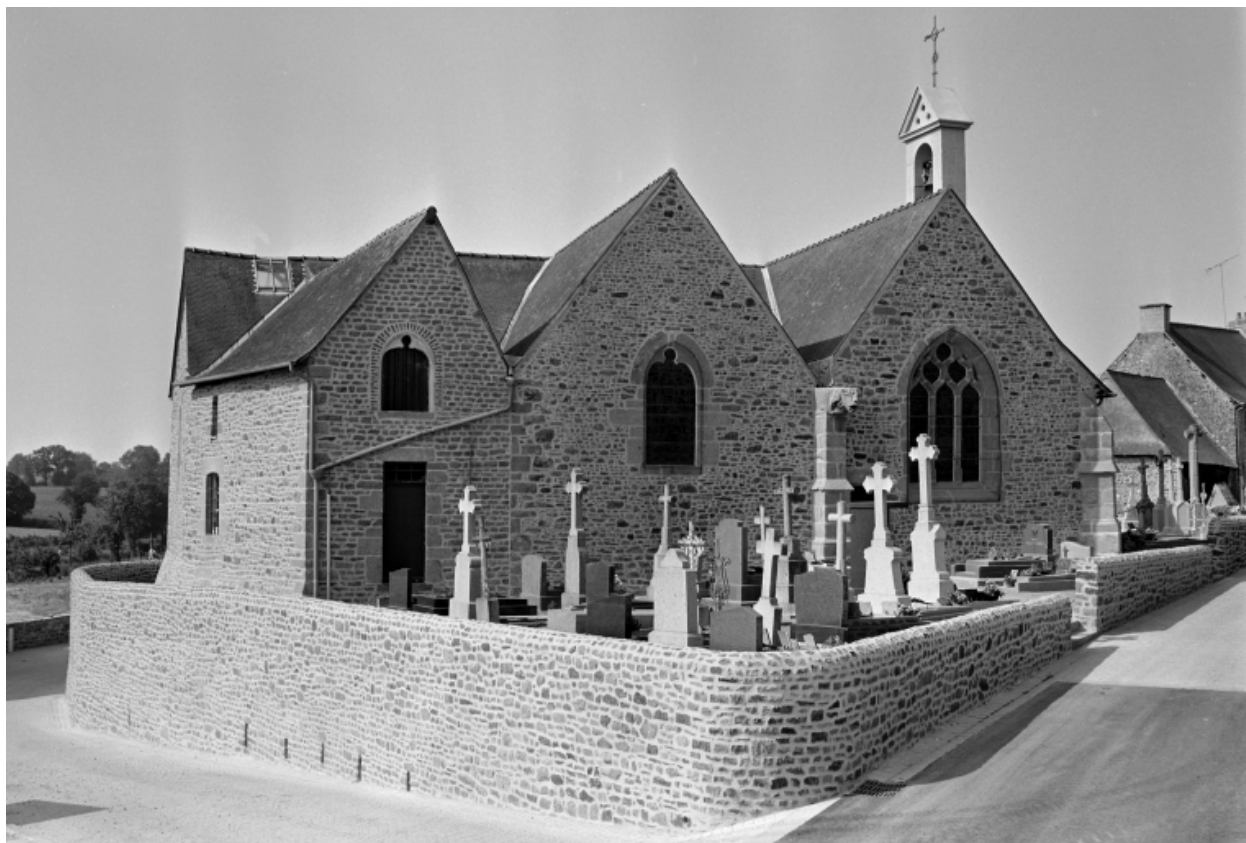
Elévation Nord-Est : vue générale
