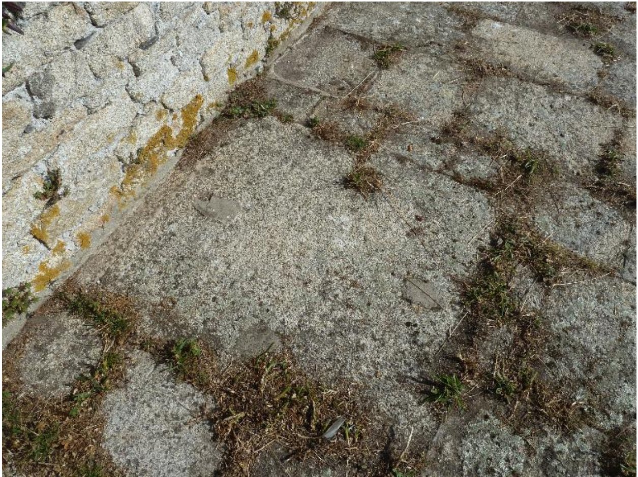
Archipel de Glénan, fort de l'île Cigogne, batterie Ouest, détail de la plate-forme nord, dé de sous-sellette avec ses goujons coupés.
