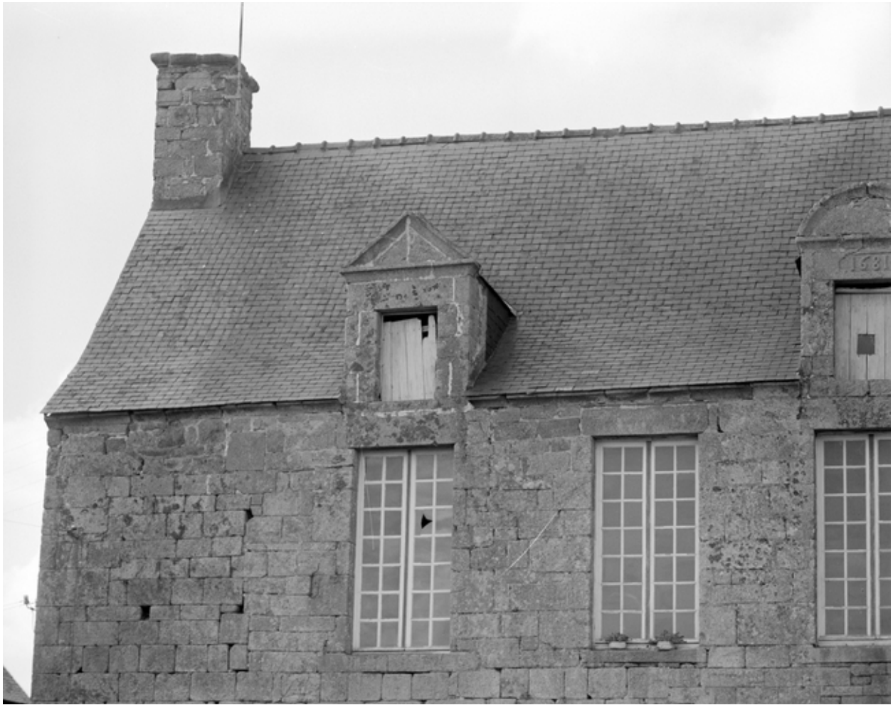
Façade sud : lucarne ouest
