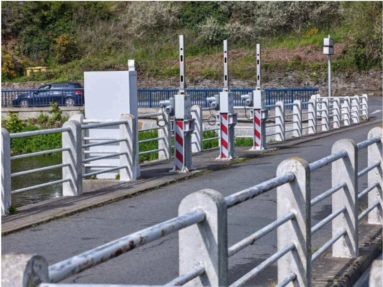
Les vannes sur le déversoir du bassin à flot
