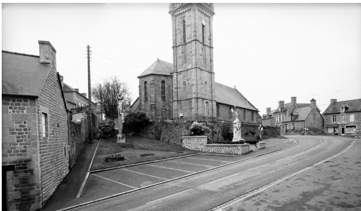
Elévation Nord-Est : vue générale
