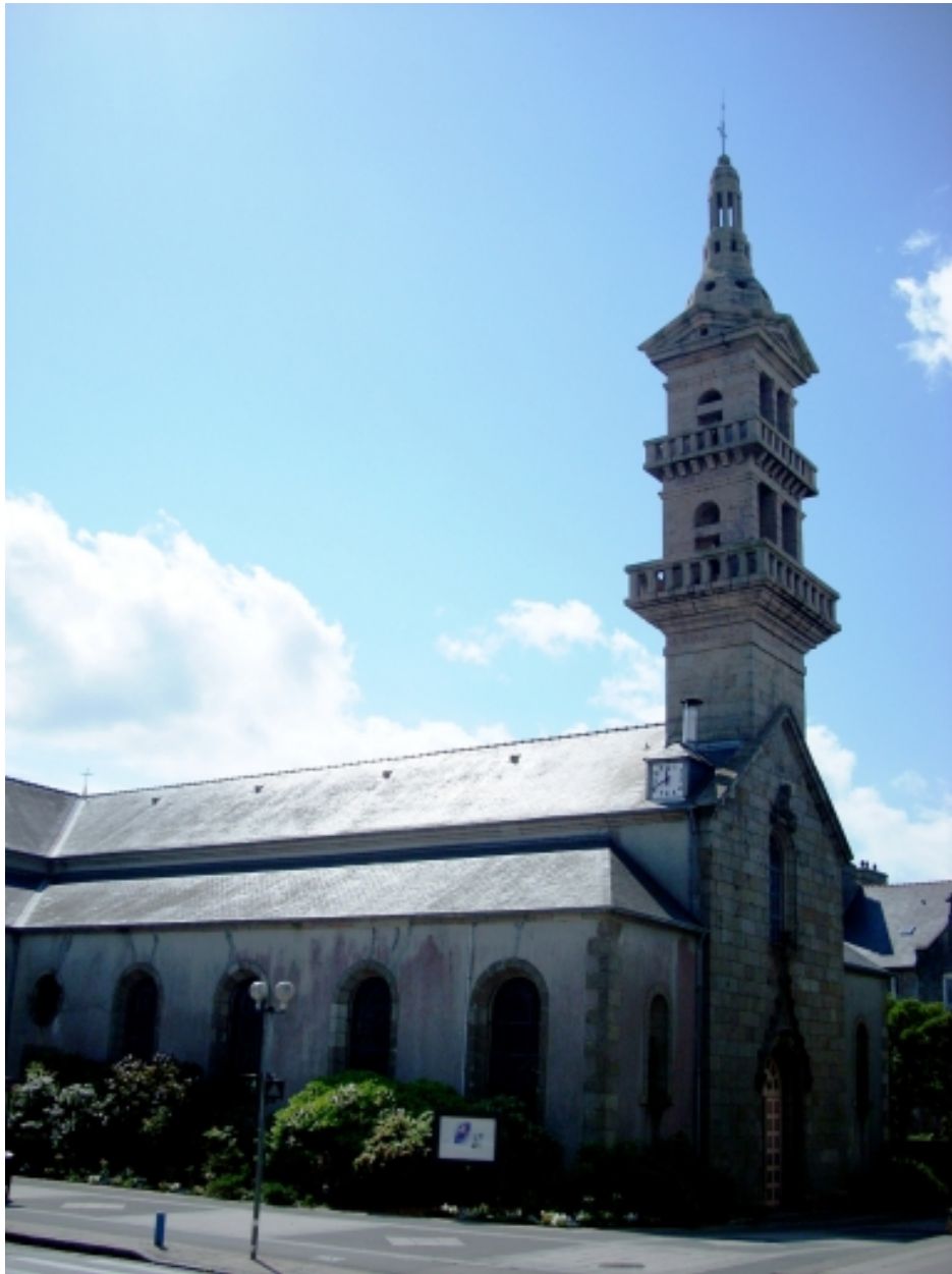
Brest, église Saint-Joseph : vue générale nord-ouest
